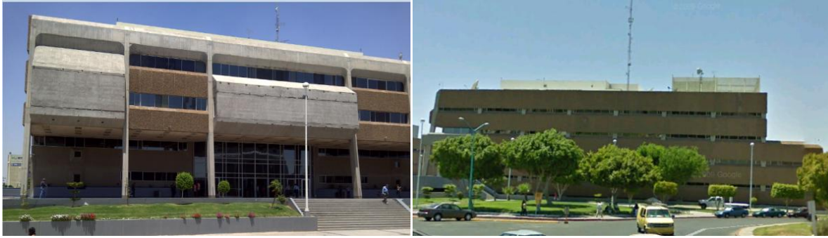
Figura 1. Fotografías del edificio del Ejecutivo del Estado de Baja California
